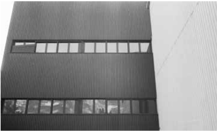
Fassade des «Neubaus» 1996
