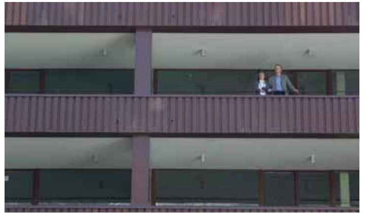
Fassade mit grosszügigen Balkoneinschnitten
