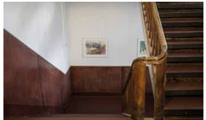
Treppe im Originalzustand belassen
