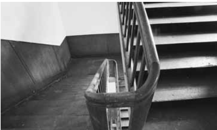
Treppe Altbau Früher
