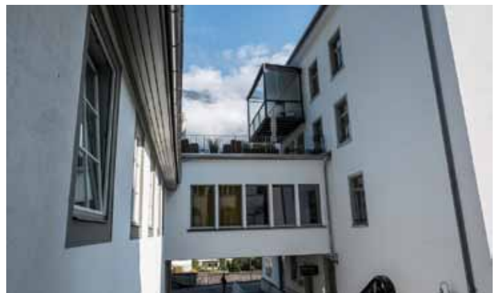
Passarelle und Terrasse 2016
