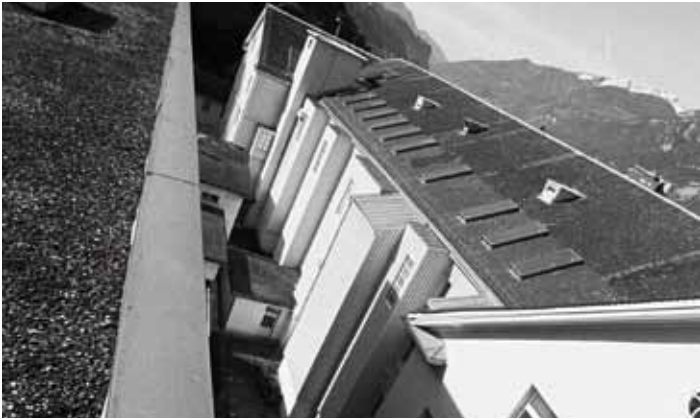
Blick vom Dach des Neubaus nach der Stilllegung 1996
